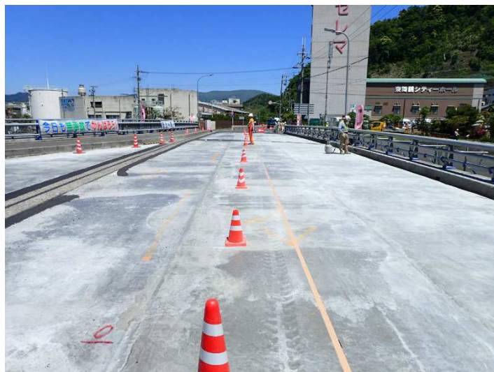
図 2-28 J-THIFCOM 敷均し完了後の松島橋
